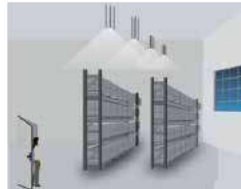
Con movimiento e insuficiente nivel de luz ambiental, el sensor enciende la luz al 100%
